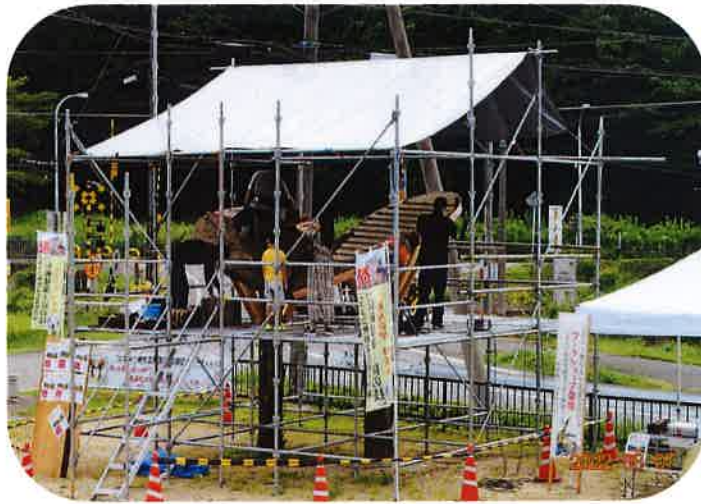
2枚目の屋根が取付けられた檜柱
